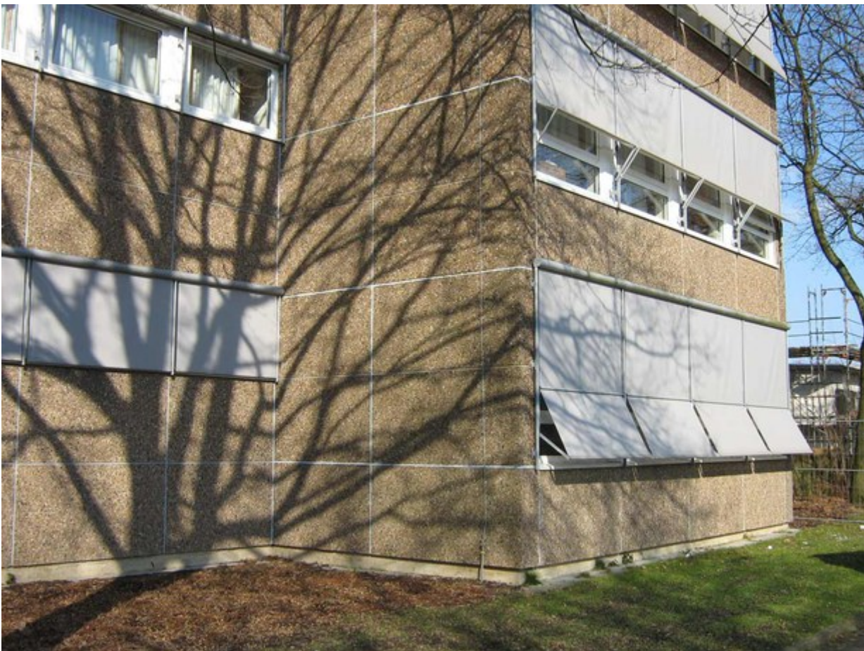
Beschattungsanlage an einer Schule
