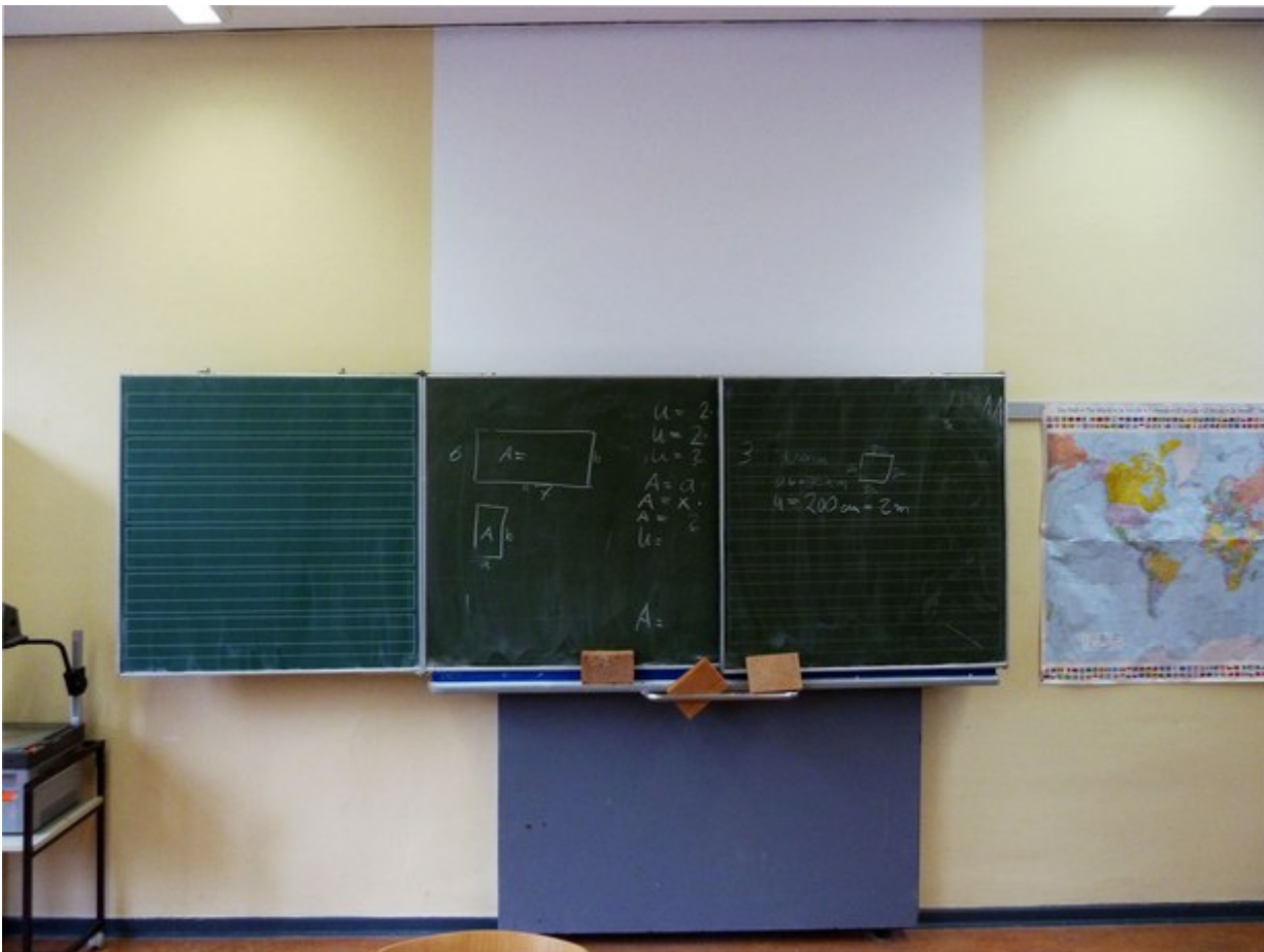
Nicht ausreichende Beleuchtung der Tafel
